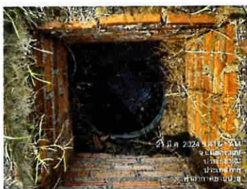
บ่อบำบัดน้ำก่อนเข้าระบบบำบัดน้ำเสียของอาคารที่พักผู้โดยสาร
